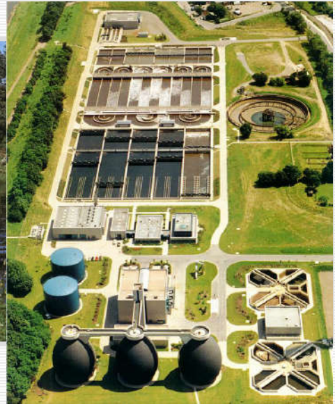
鲁尔河协会Duisburg-Kablerfeld 污水处理厂
