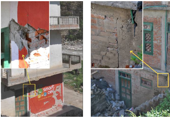
(b) Singati(调查点 3)2 个结构的剪切破坏柱
