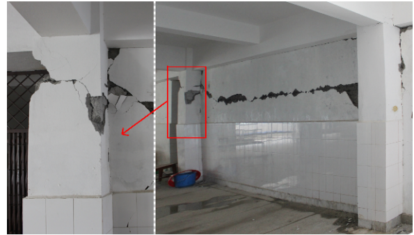
(d) 与无开洞填充墙相邻的柱顶剪切破坏
