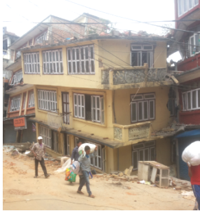
(b) Ms7.5 余震后倒塌
