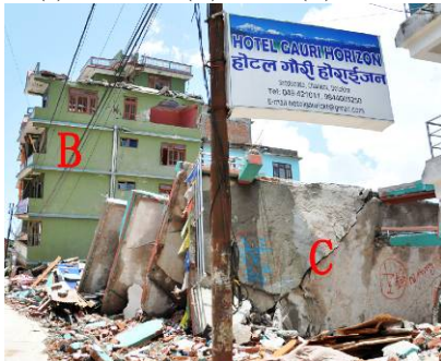
(b) 坐层(B)和碰撞倒塌(C)的框架
