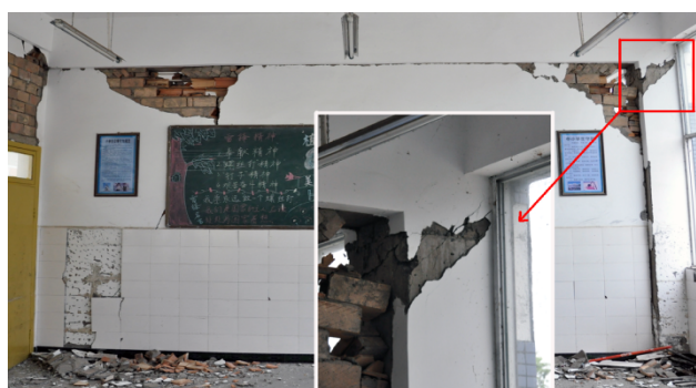
(a) 上里中学底层框架柱(2013 芦山地震)
