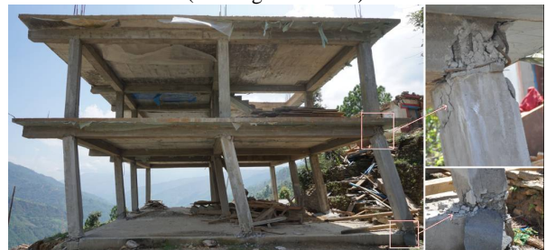
图10 Singati(调查点3)严重破坏的RC框架
