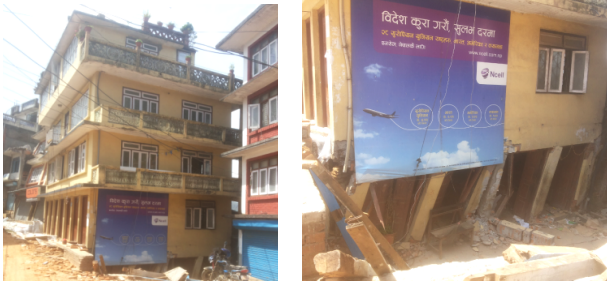
(a) 2015 年 5 月 12 日 Ms7.5 余震之前严重破坏
