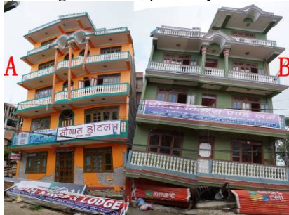
(a) 严重破坏(A)和坐层(B)的框架
