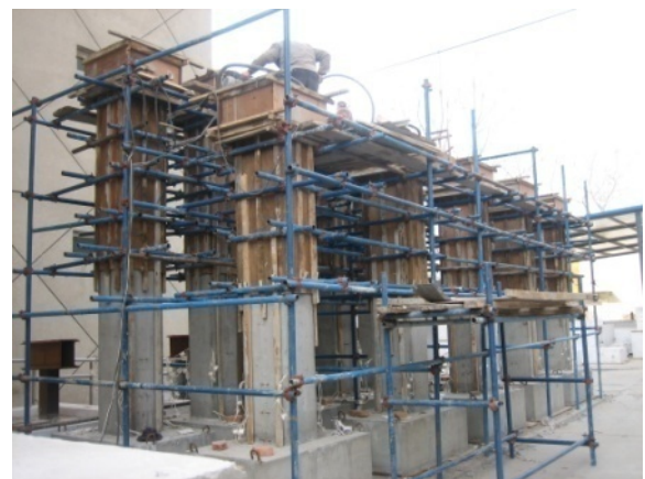
图3 桥墩试件制作照片
