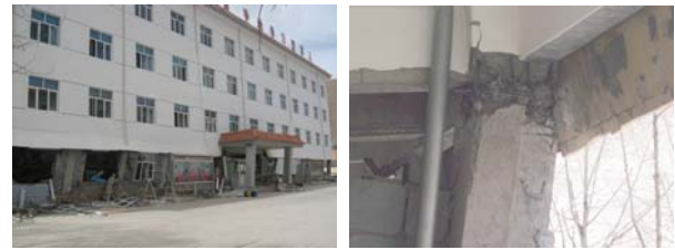
(a) 底层严重破坏 (b) 底层柱端破坏
