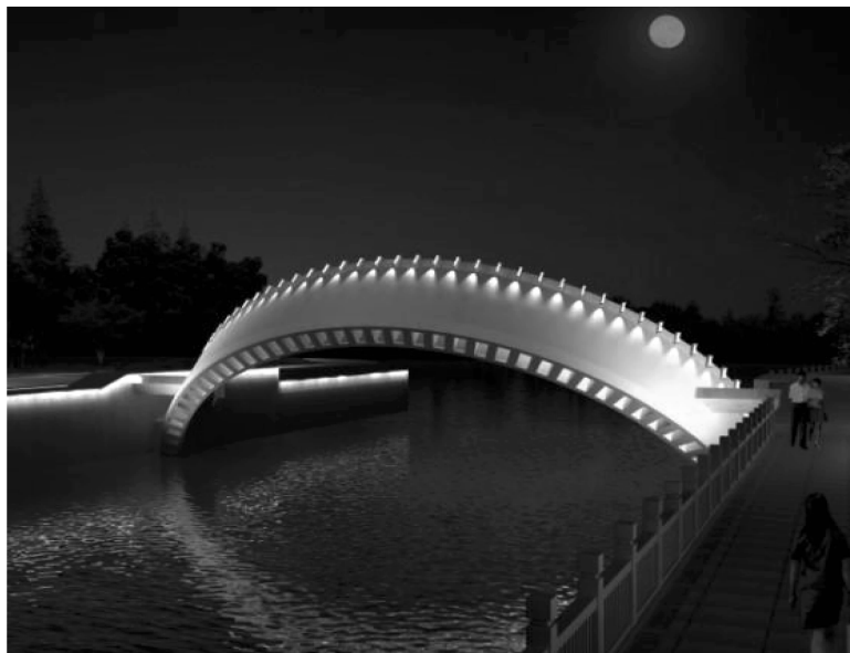
图6 上翻式拱形钢闸门+液压启闭机
