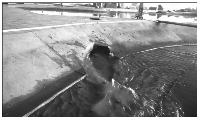
图7 滞洪区泄水闸出口局部流态
