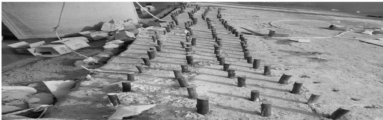
图4 静力爆破堵孔示意
