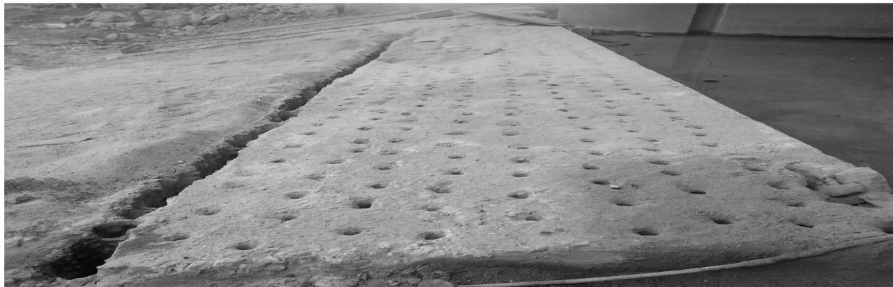
图3 现场实际钻孔布置示意
