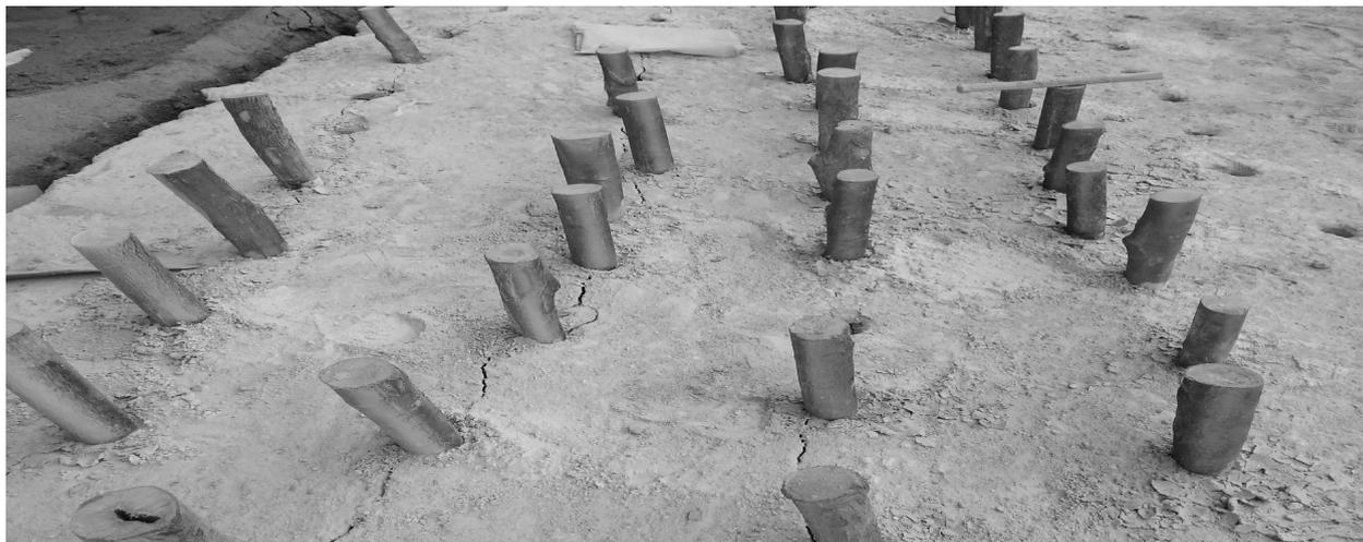
图5 静力爆破实际效果
