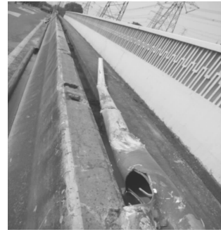
图3 实际交通事故中护栏 Fig. 3 Barrier in real accident
