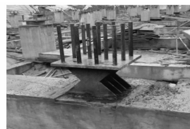
图 6 抗风支座实体模型 Fig. 6 Entity model of wind-resistant support
