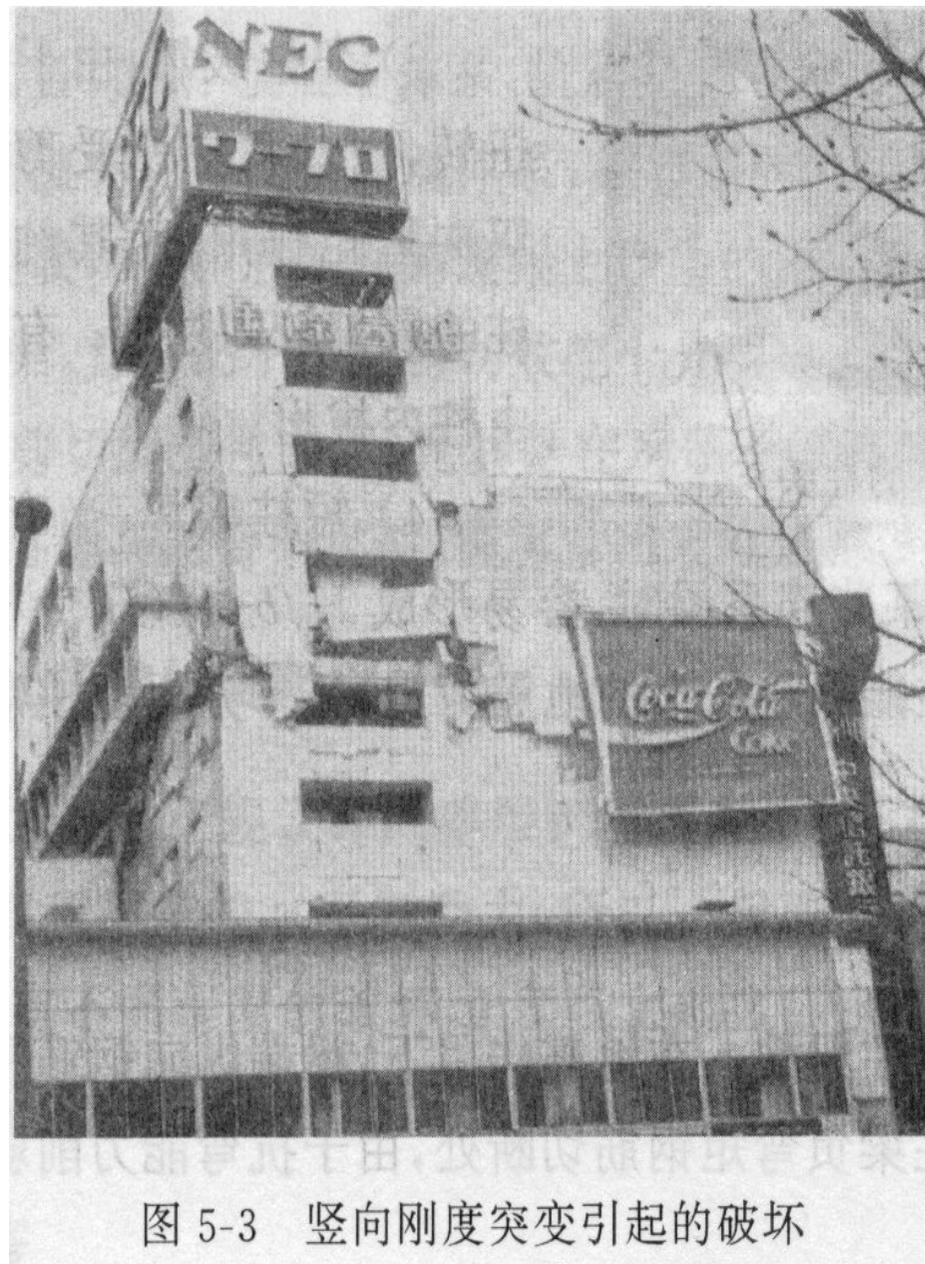
图 5-3 竖向刚度突变引起的破坏
