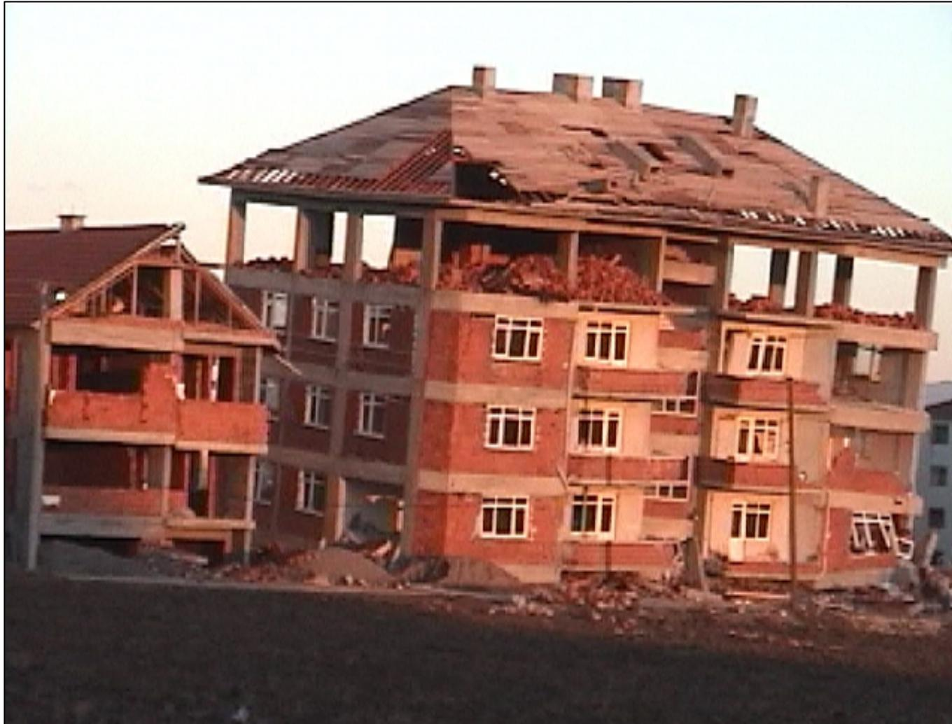
填充墙破坏的主要原因是：墙体受剪承载力低，变形能力小，墙体与框架缺乏有效的拉结，在往复变形时墙体易发生剪切破坏和散落。
