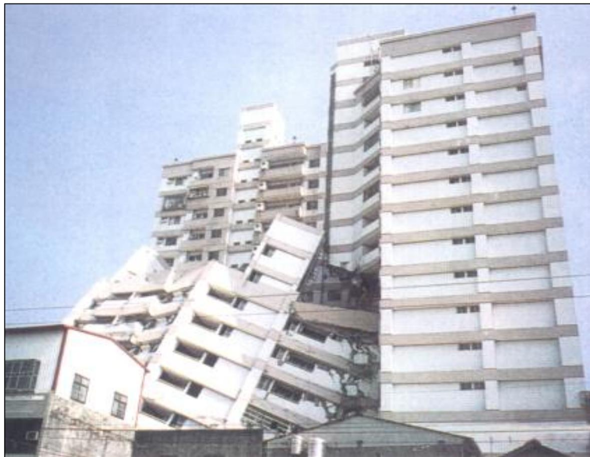
彰化县员林镇邦富贵名门大楼座落在中山路惠明街口，为16层钢筋混凝土集合住宅大楼。地震时其中一栋倾倒靠在呈L型平面大楼上，柱子间距7至10米。造成倾倒的原因是底层柱子数量少，间距太大。
