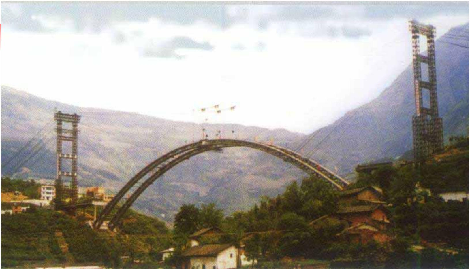
大跨径钢管砼拱桥目前主要采用缆索吊装-斜拉扣定施工法，在国外较早应用，属无支架施工，其思路为借助钢骨架阶段吊装的扣索来调整砼浇筑阶段内力。通过扣索的张放，给拱肋施加一定量的拉力，减小应力，控制变形。
