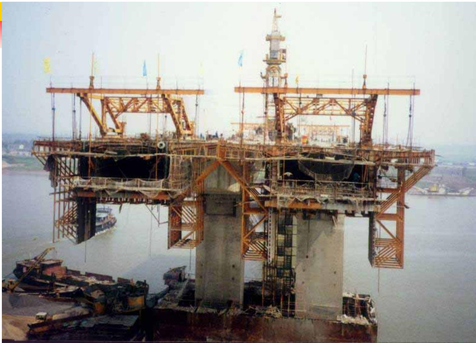
**挂篮的预压加载可用吊水桶方法，主要检查挂篮主桁架的受力及变形量以及后锚系统的安全性。**
