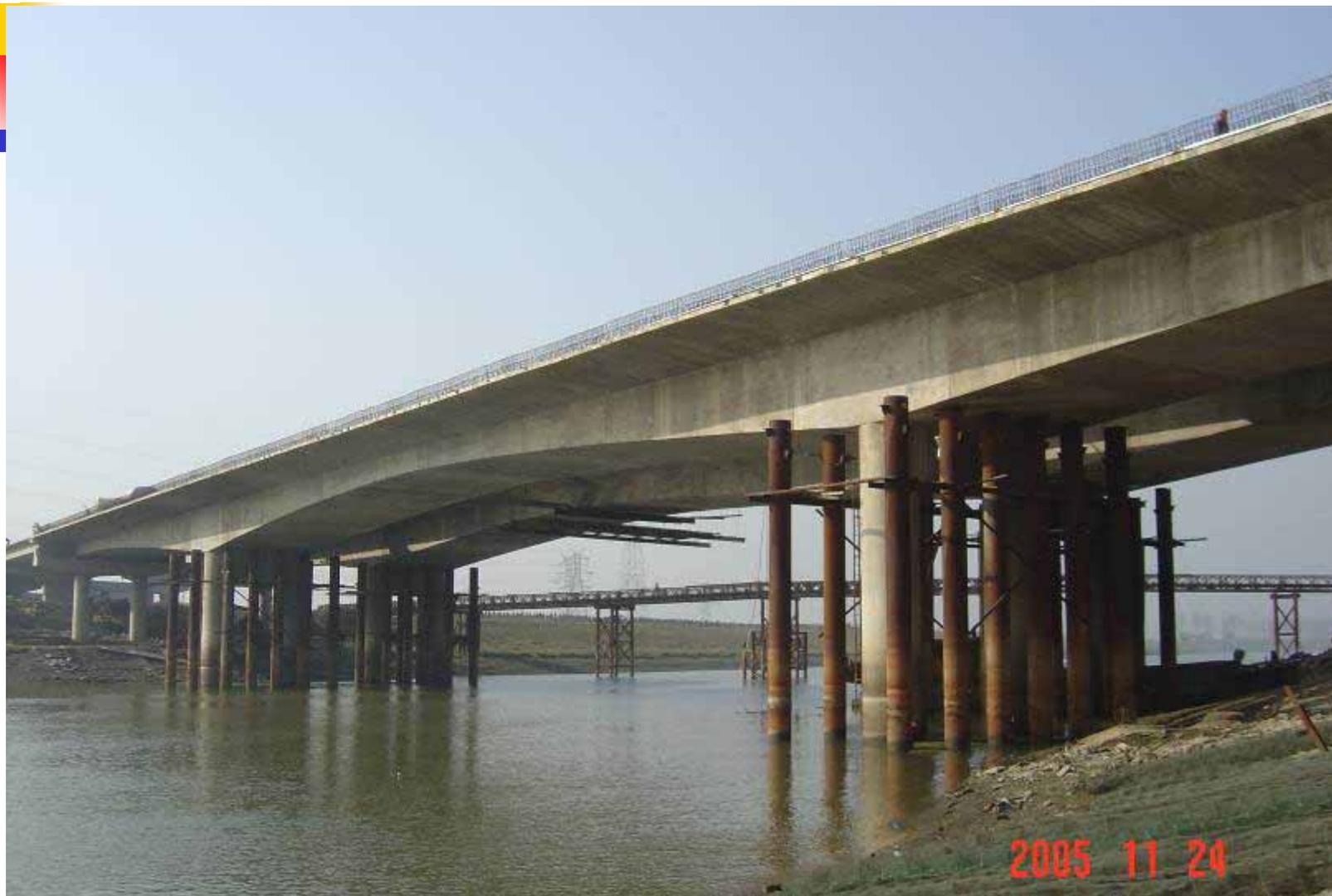
南京马汊河85m跨PC连续刚构梁桥建成后的情景。
