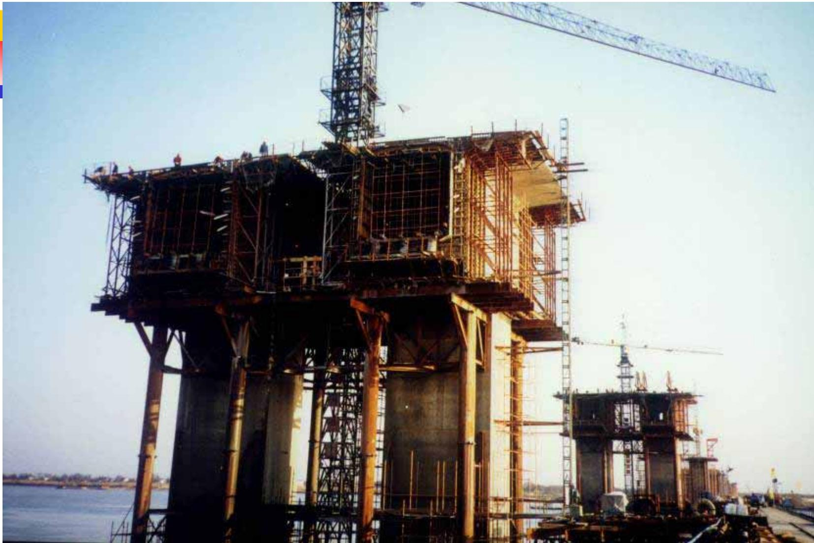
0#块长8m，二桥采用两侧加临时支墩，其优点为支架变形小，无须预压；缺点为支撑材料用量较大。
