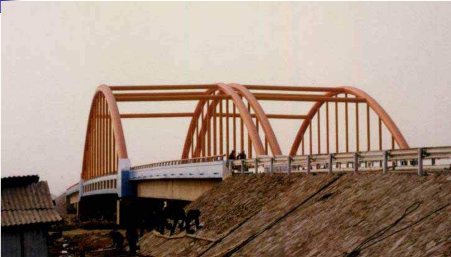
下承式系杆拱桥在江苏得到大量应用，解决了江苏软土地基上拱桥拱脚的推力问题。缺点为河流通航高度不够。
