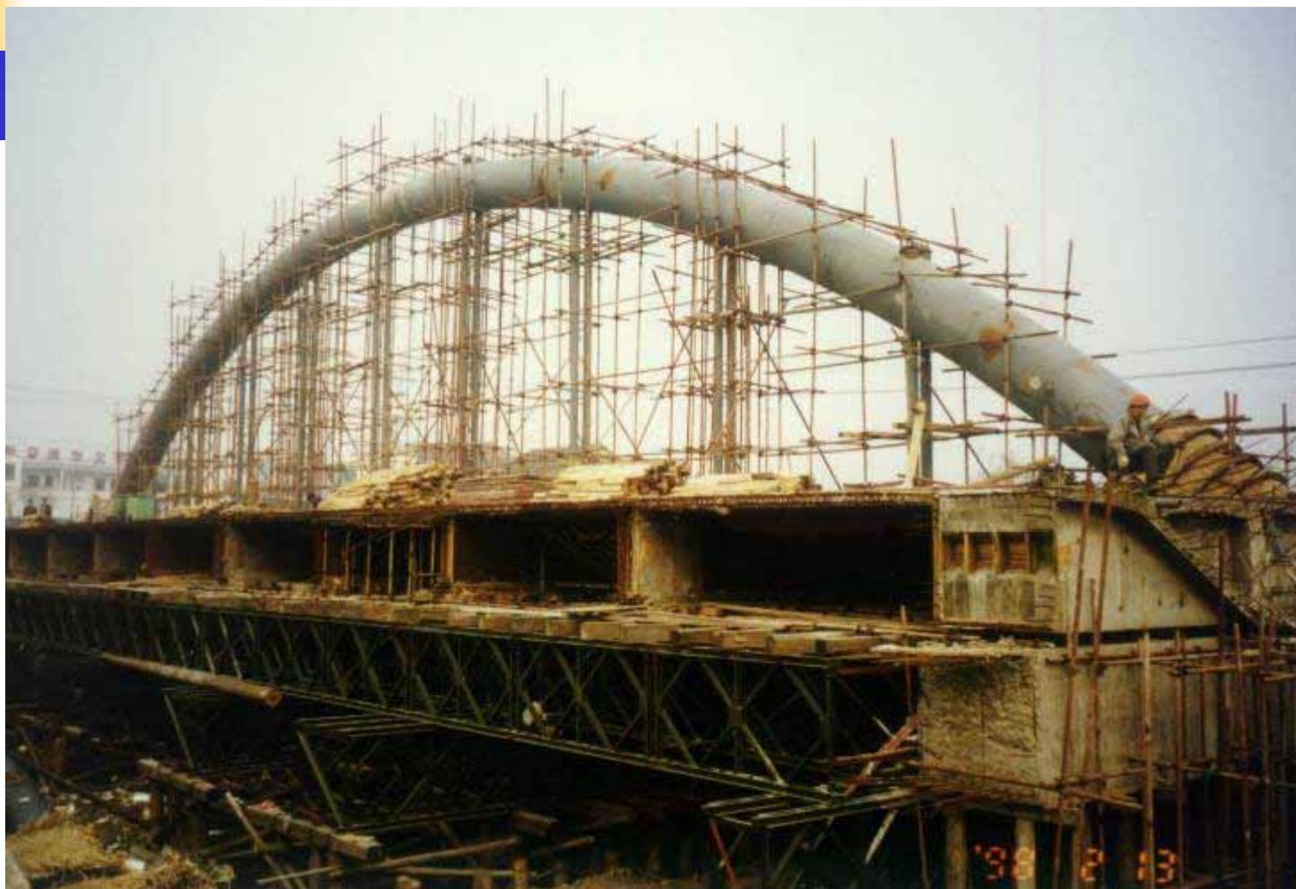
苏州的齐门桥为钢管砼拱桥与预应力箱梁桥的结合，跨度为50m，箱梁的高度减至最低，以取得最大通航高度。
