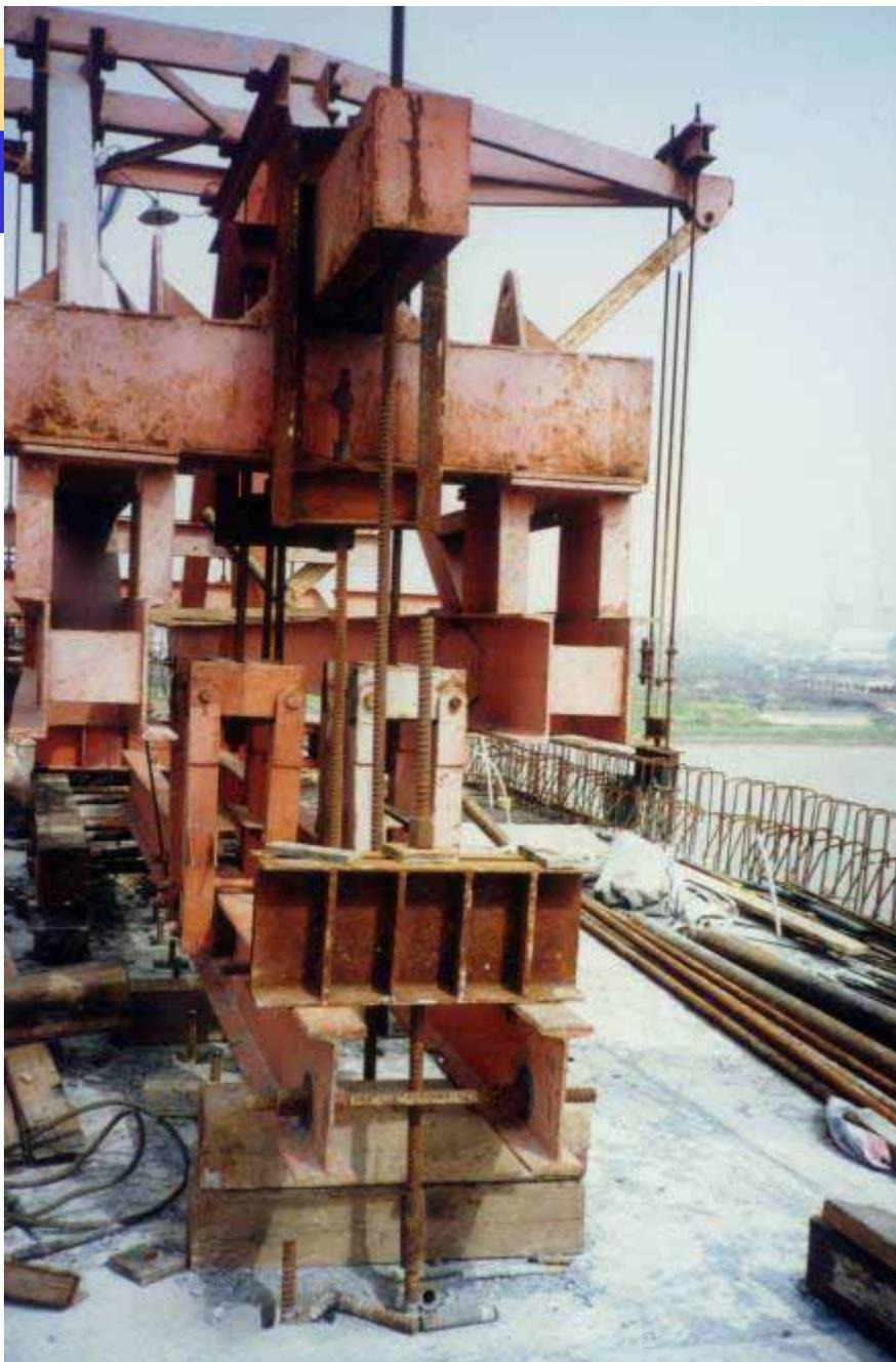
为保证施工挂篮的安全，应验算挂篮在空载行走状态和砼浇筑状态时的倾覆稳定（稳定系数不小于1.5）。
