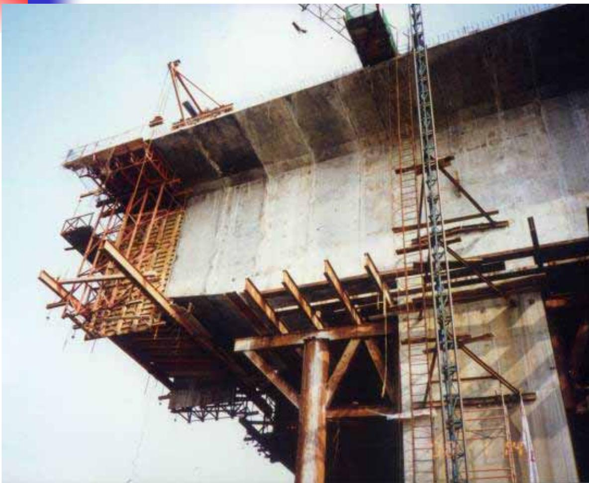
为节省支架费用，有的工程采用三角支架临时锚固，支架直接与墩身预埋件焊接。一般0#块可分两次浇筑，第一次浇筑底板及部分侧壁（倒角处），第二次浇筑的砣及施工荷载由第一次浇筑的砣结构承受。
