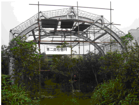
图 1 由钢拱架和环形网组成的柔性棚洞
