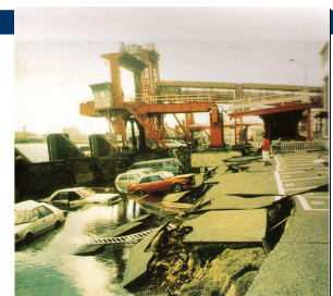
在日本 HigashiKobe 轮 渡破坏的码头墙
