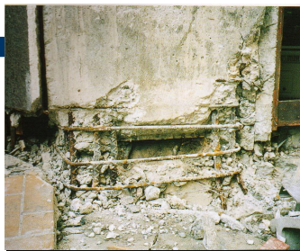
破坏的柱基础
