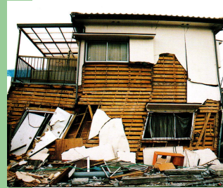
普通木结构房屋的典型破坏
