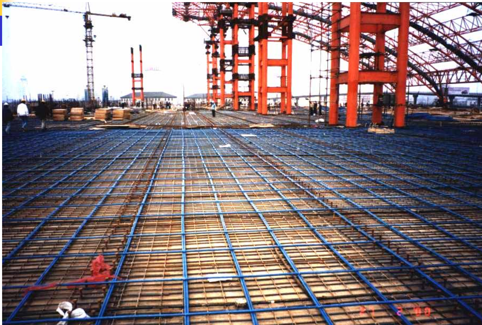
南京国际展览中心楼板中铺放双向无粘结预应力筋
