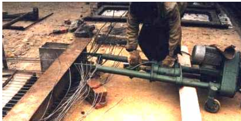
电动螺杆张拉机图
