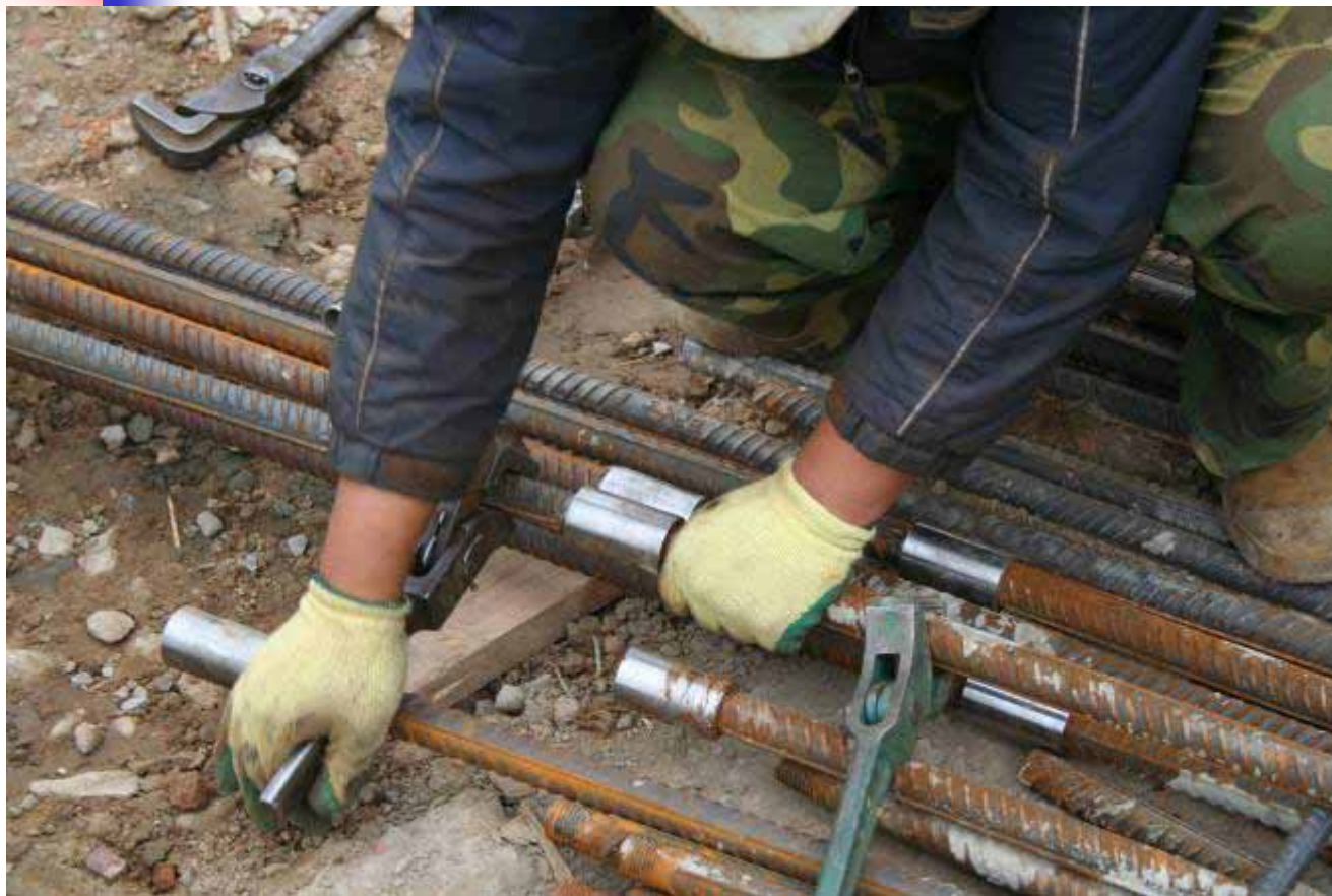
工人 在工地用 扳手拧接 头螺牙
