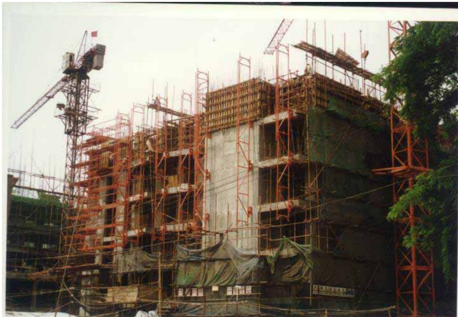
爬架片的安装
