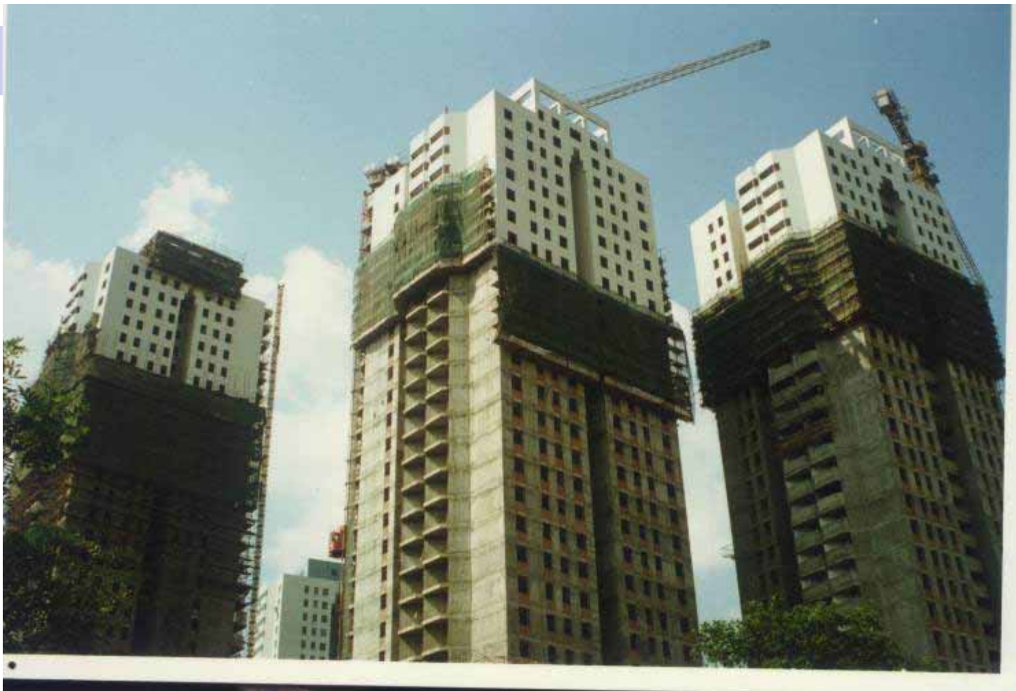
南京估衣廊30高层住宅应用情况
