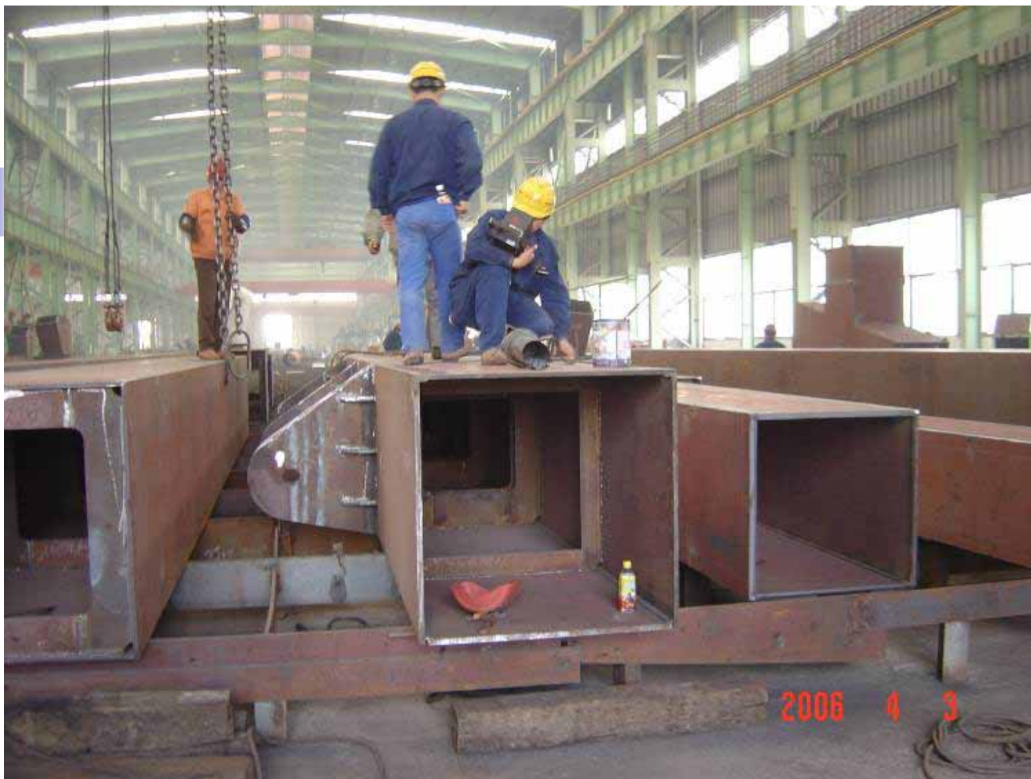
图为用超声波钢柱的焊缝进行探伤检查。
