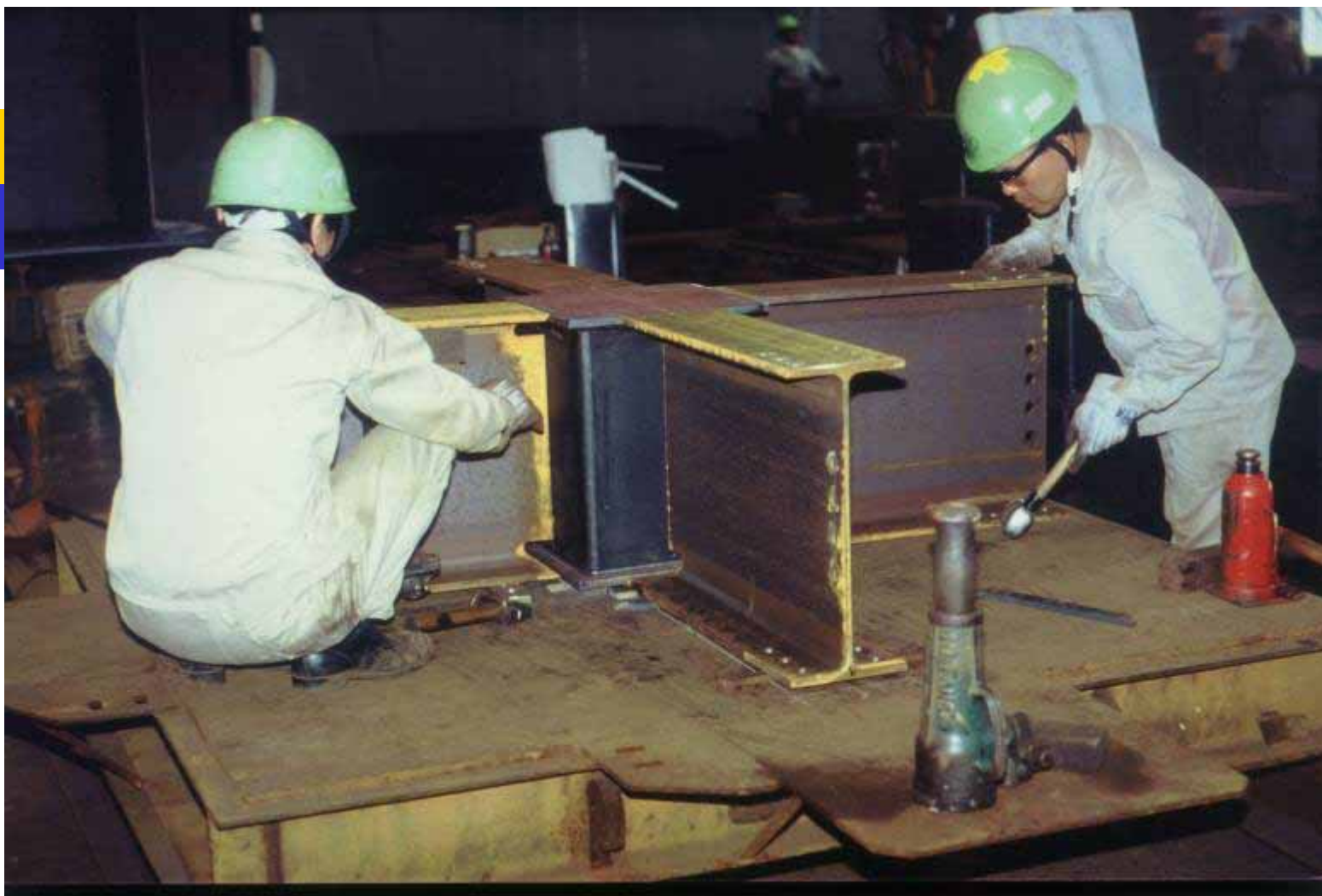
在工作台上对梁柱节点进行小组拼，照片中为box柱
