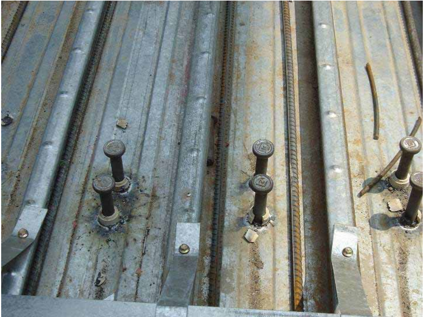
焊接完成的栓钉。
