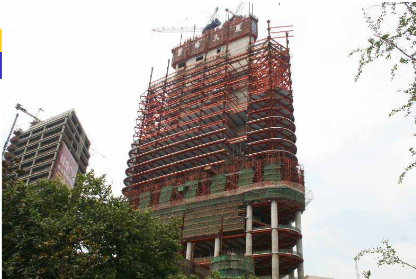
位于南京鼓楼的紫峰大厦采用混凝土核心筒外钢框架结构。
