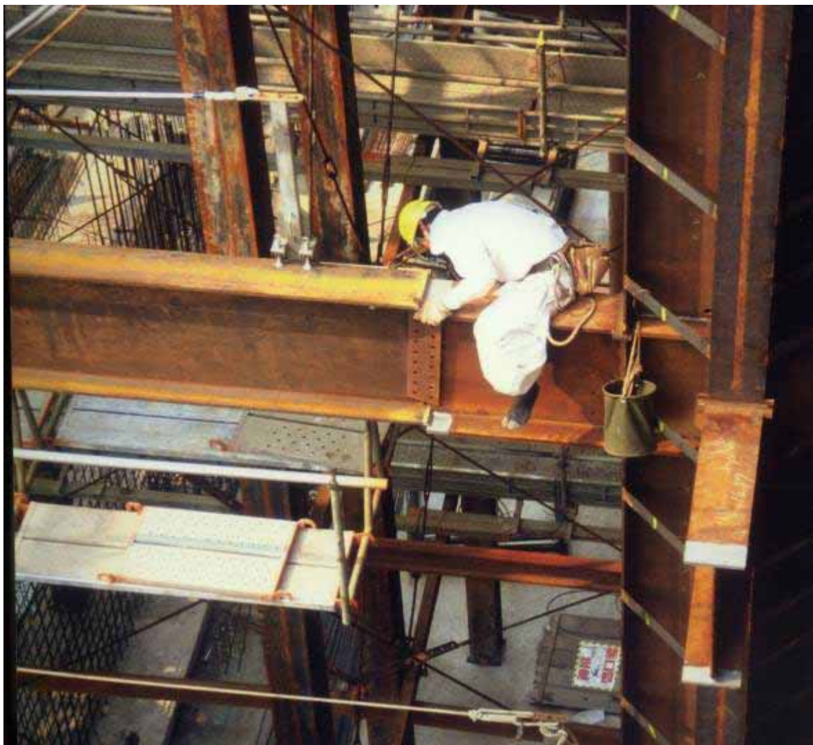
安装工人骑跨在短梁上，先安装腹板的连接板。
