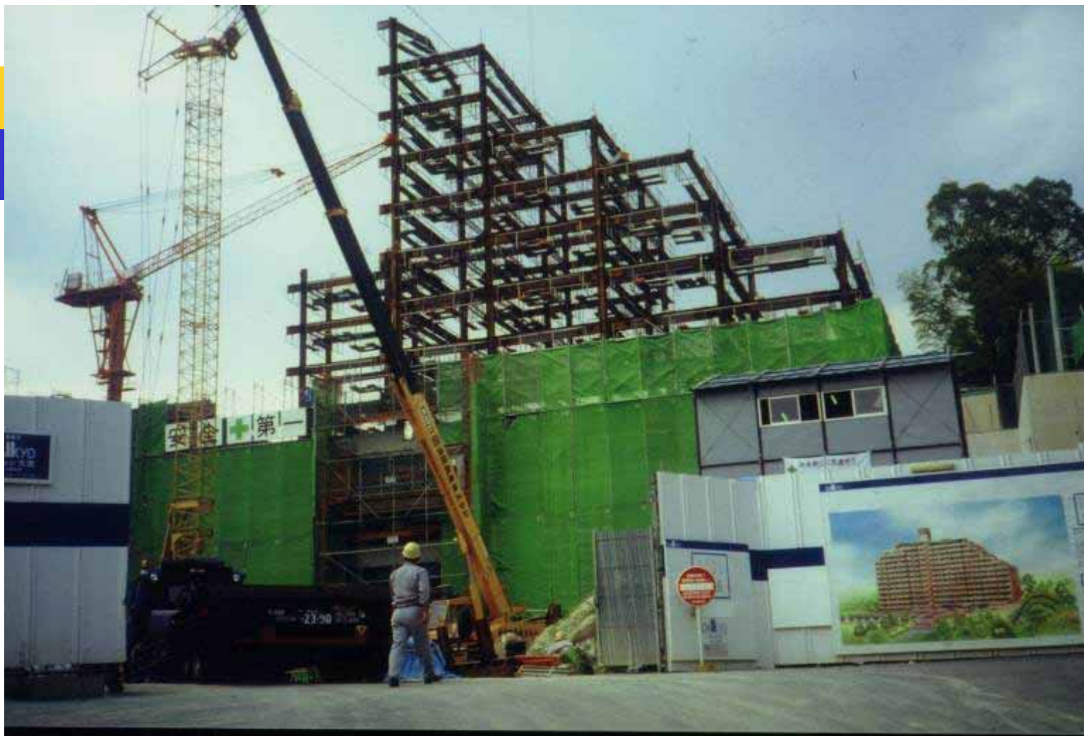
由日本五洋建设施工的钢结构住宅正用退层综合吊装法进行吊装。
