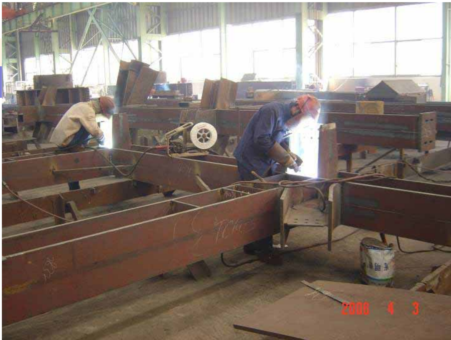
在工作台上对梁柱节点进行小组拼，照片中为box柱
