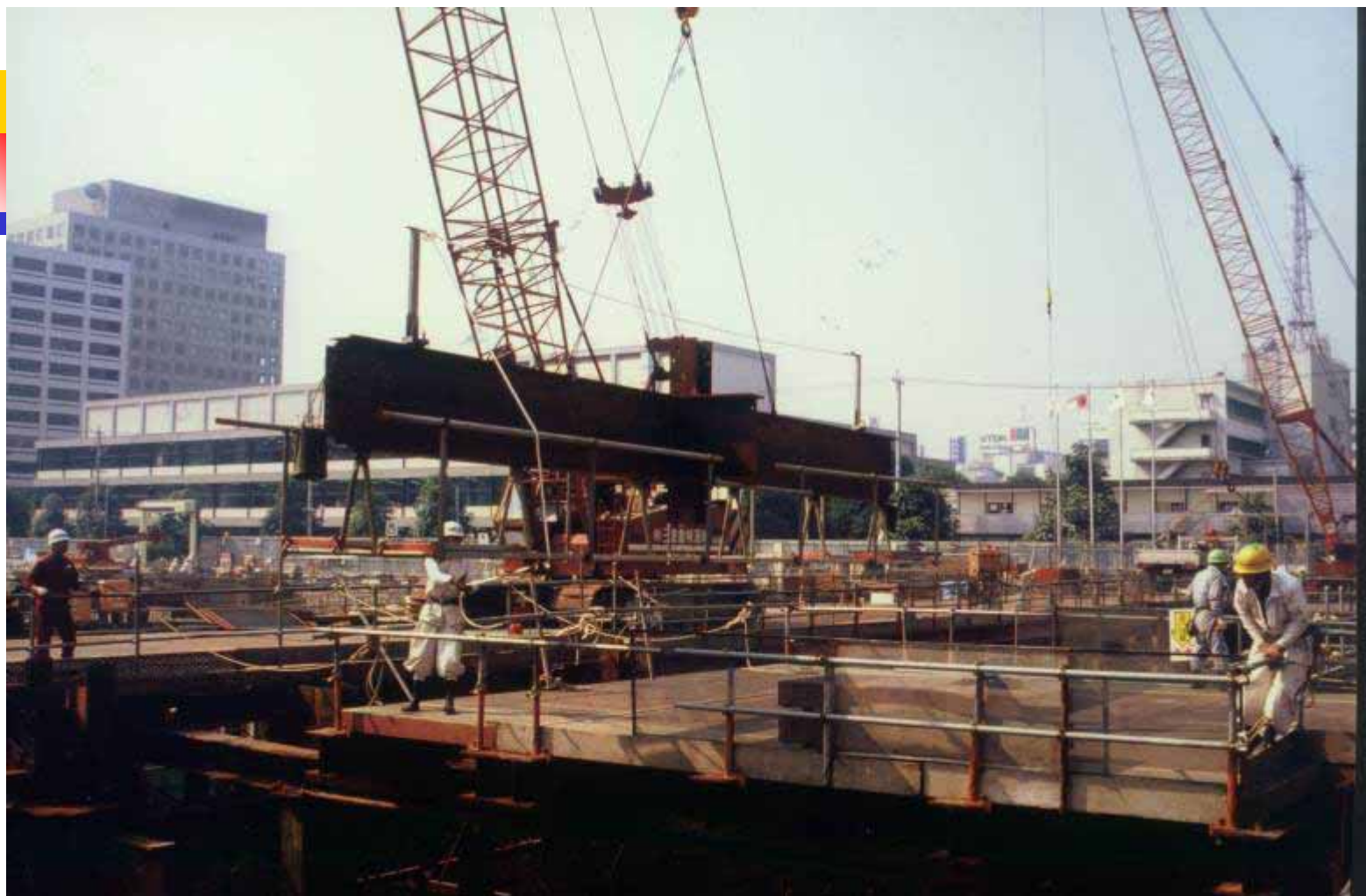
钢结构现场安装时，中间梁段运至现场。
