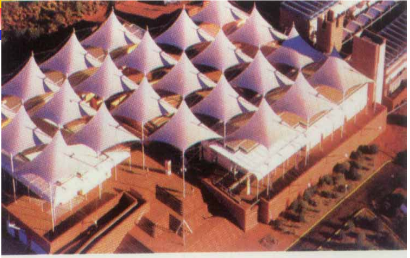
澳大利亚某修养地中心庭园鞍型膜面群
