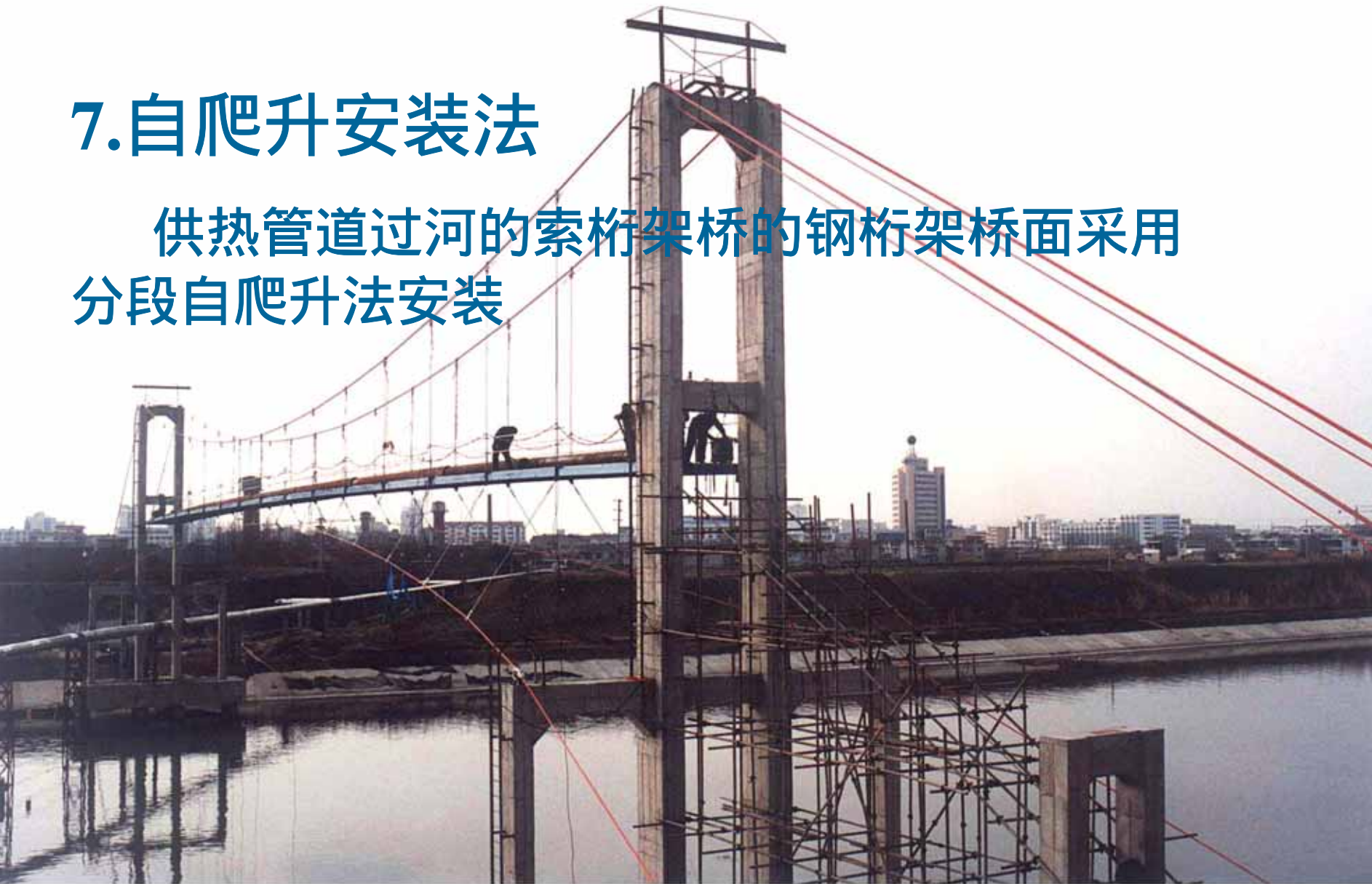
东台热电厂供热管线专用悬索桥
