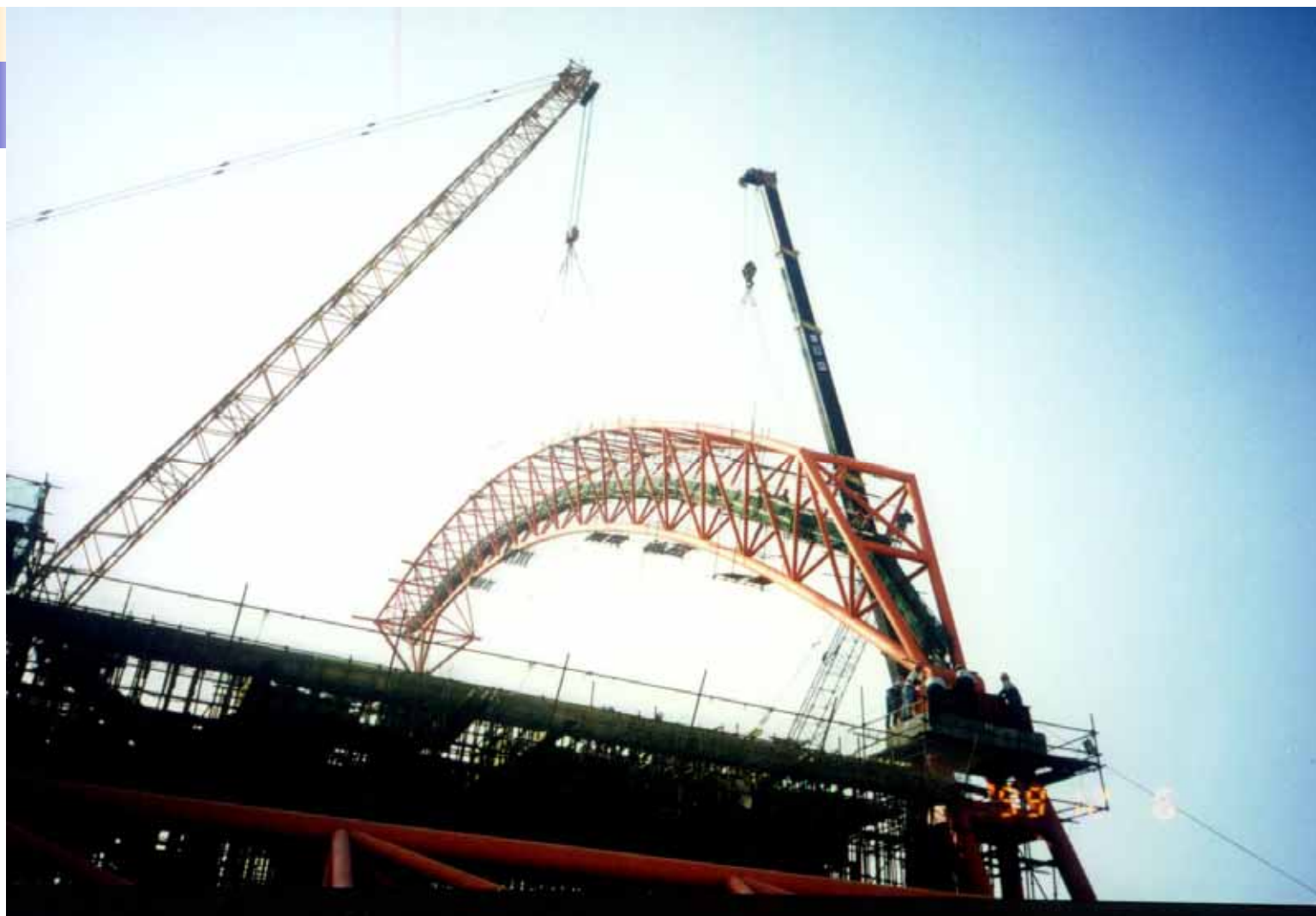
德国产的500t德玛克汽车吊主吊，120t吊机溜尾
