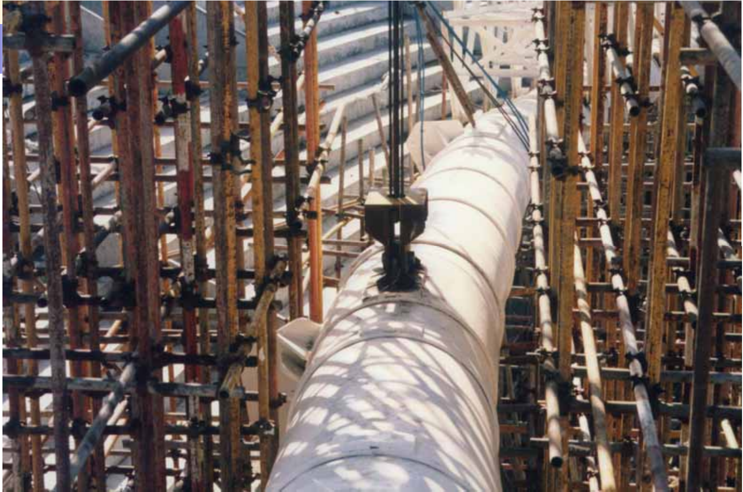
劲性内环梁呈马鞍形的空间曲线，从上向下看为椭圆环。图为钢管环梁的提升点装置。
