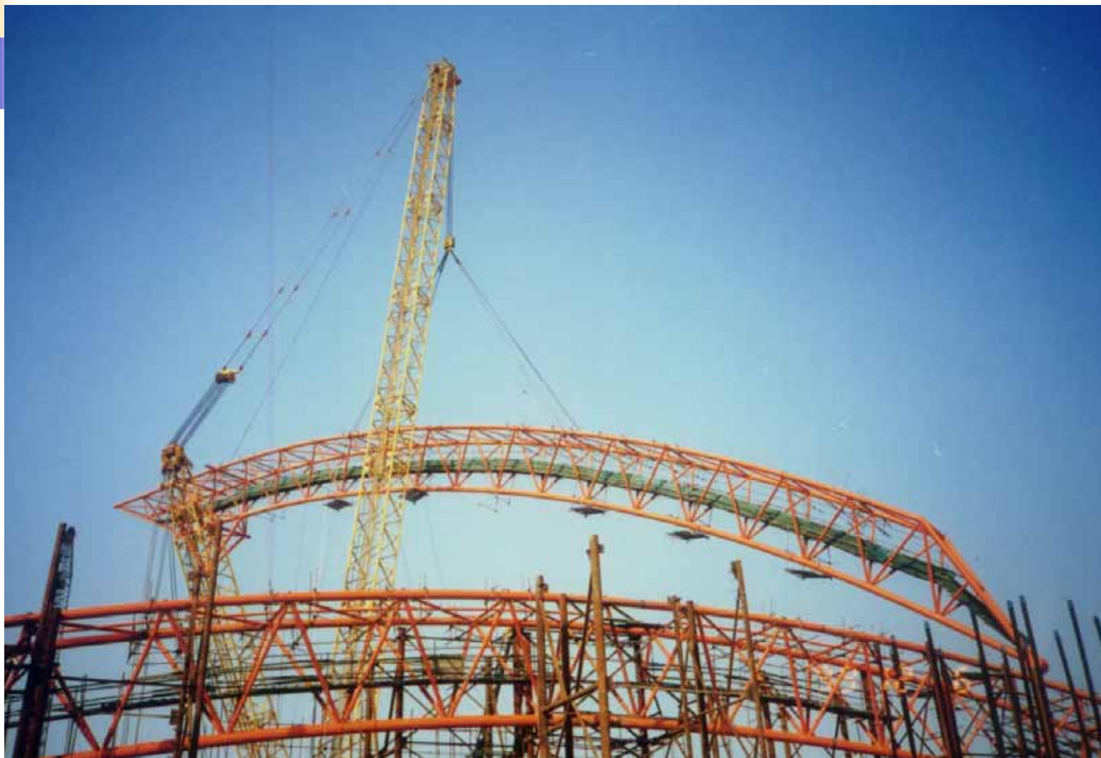
用德国产的500t德玛克汽车吊吊起钢拱架
