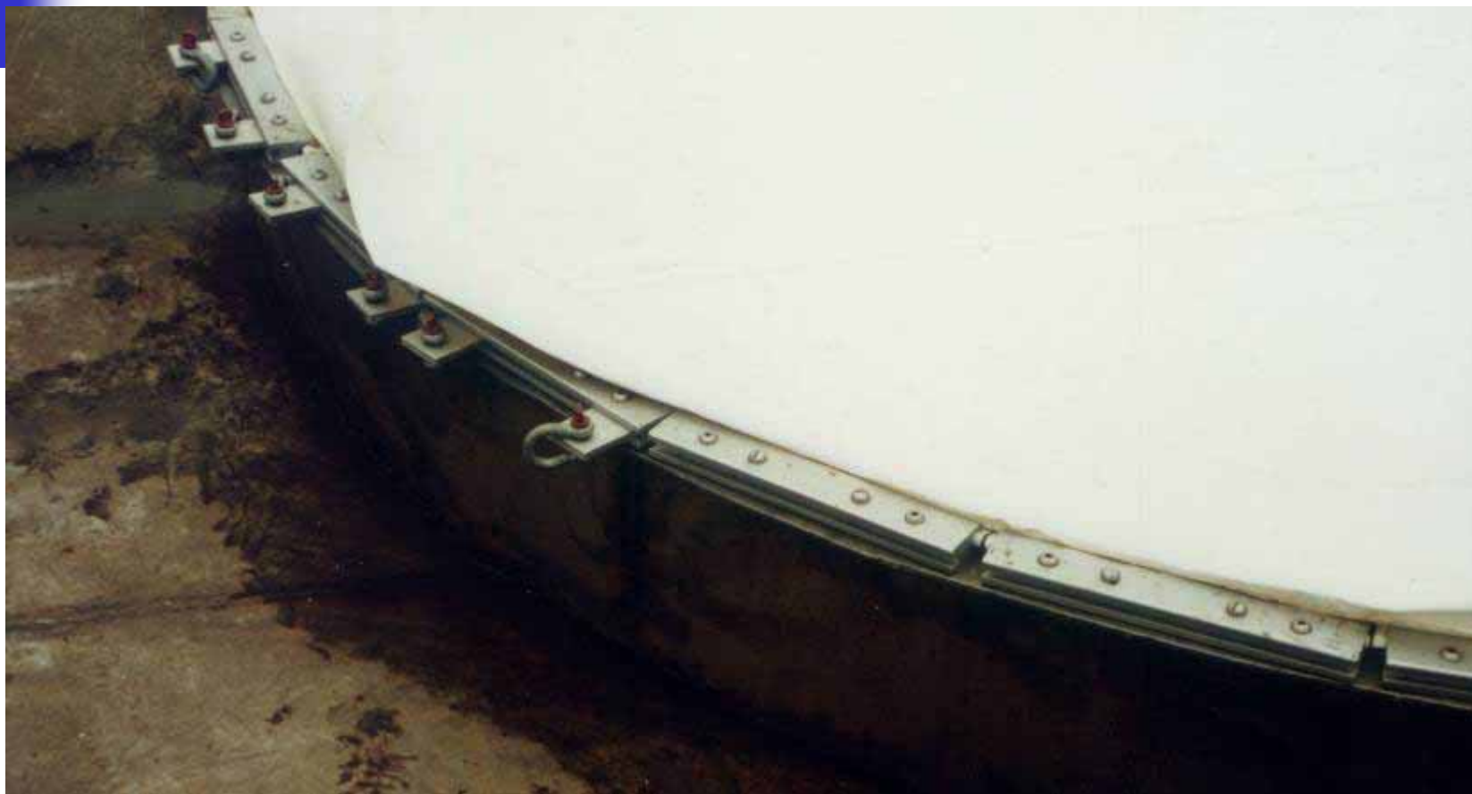
膜边缘的牵拉装置。
