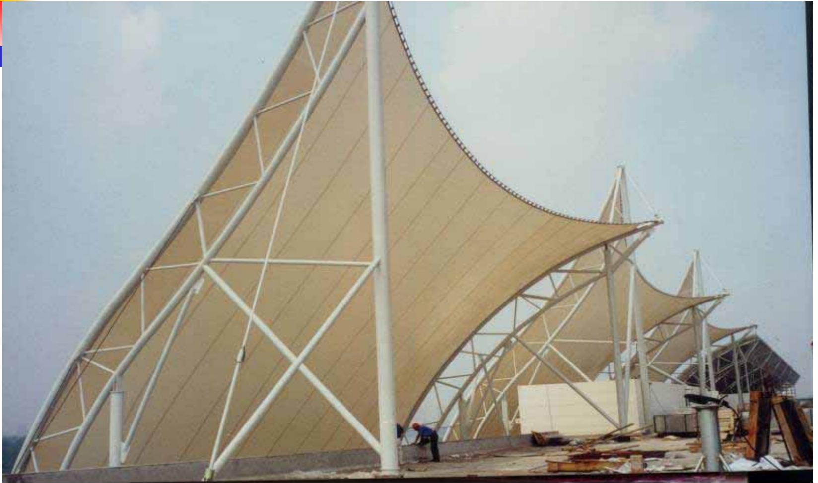
南京国际展览中心的屋顶设计了三张风帆膜。
