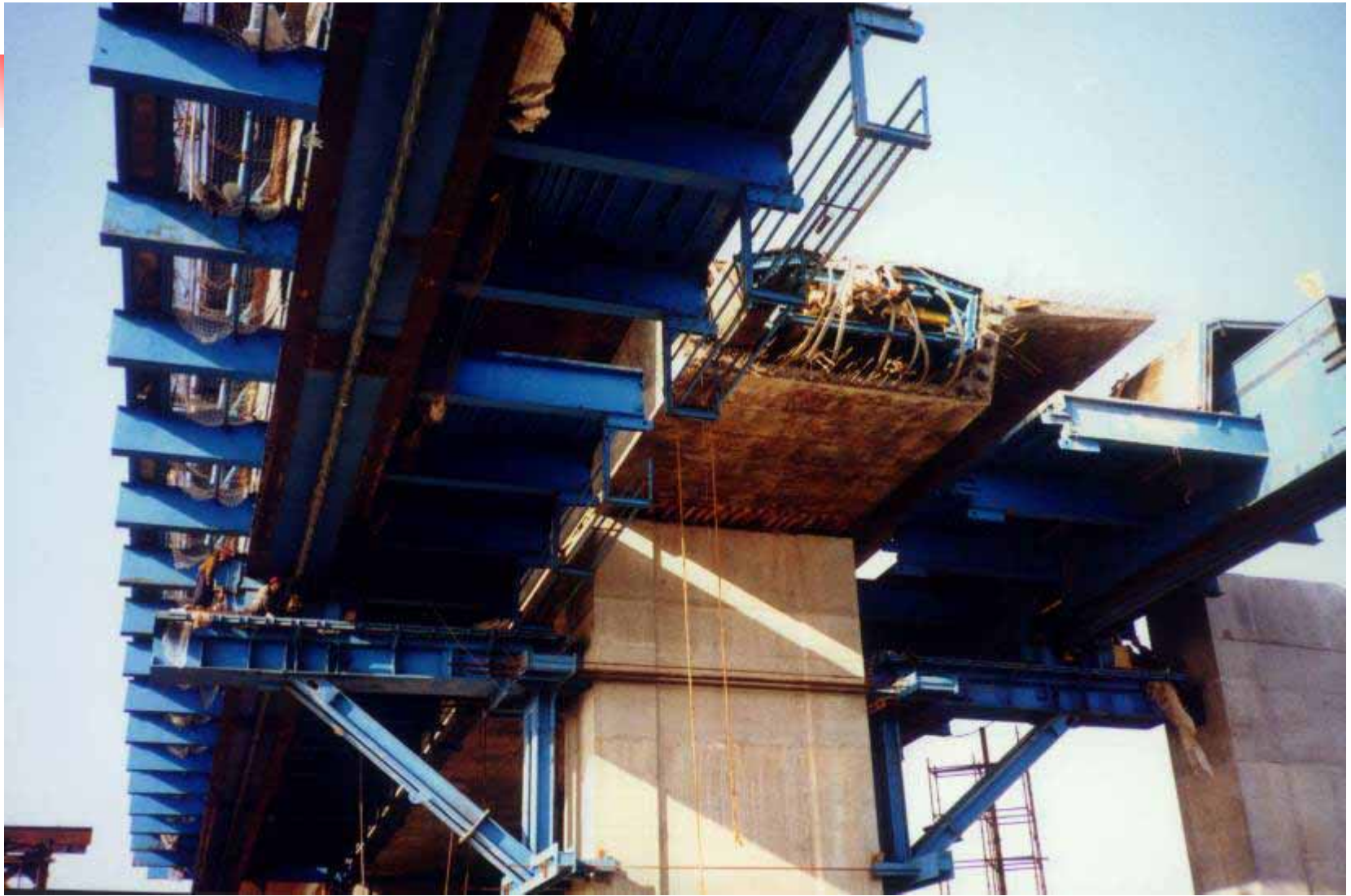
箱梁内模沿滑轨移动。
