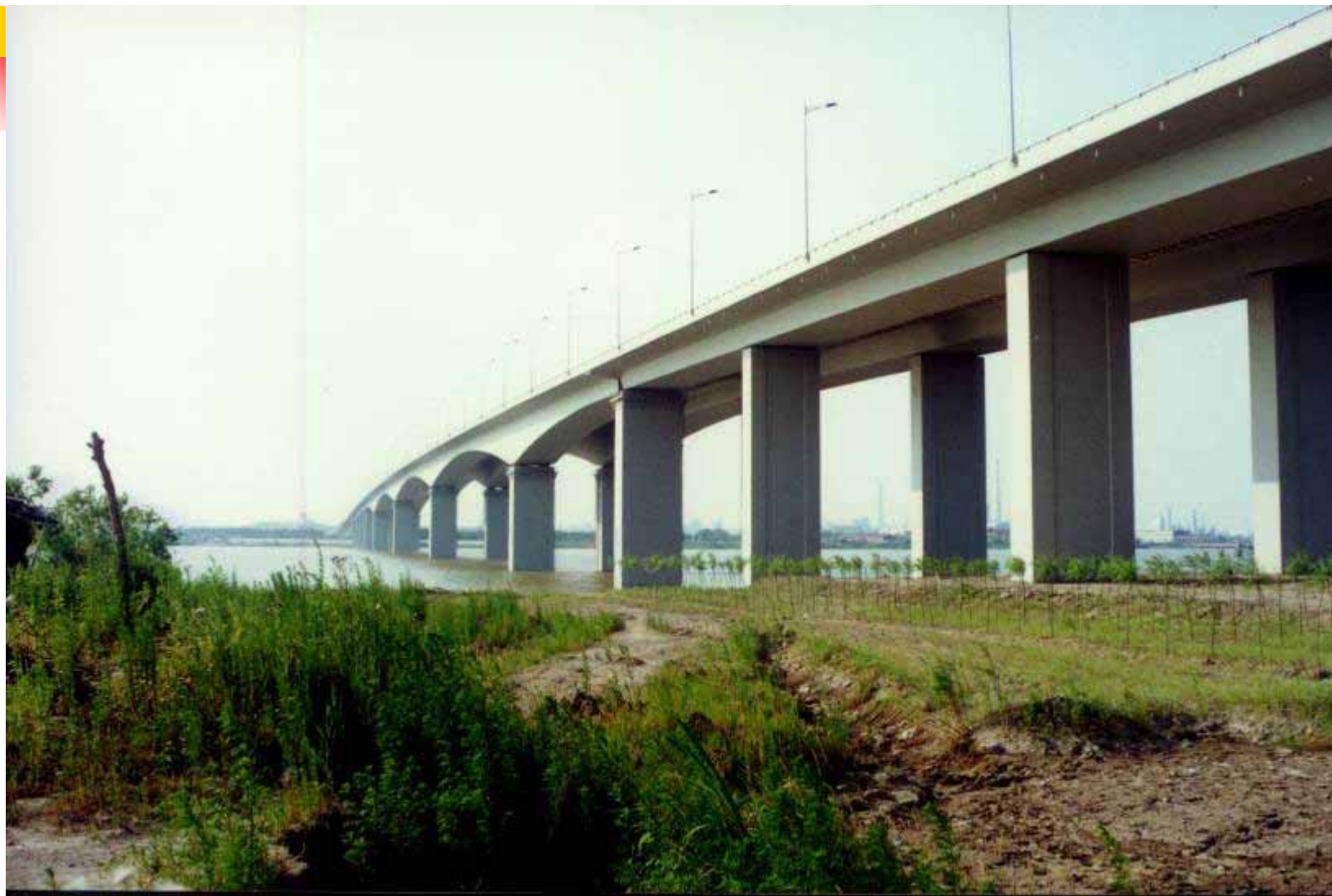
南京长江二桥北汊的连续梁桥建成后的情景。
