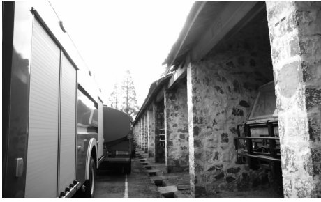
图4 某部石砌结构的车炮库房
