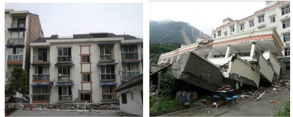
图 3 汶川地震中框架结构的层屈服破坏机制震害
