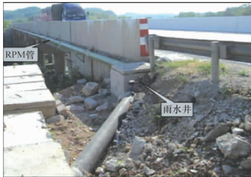
图3 桥面径流RPM管收集系统设置完成后实际情况
