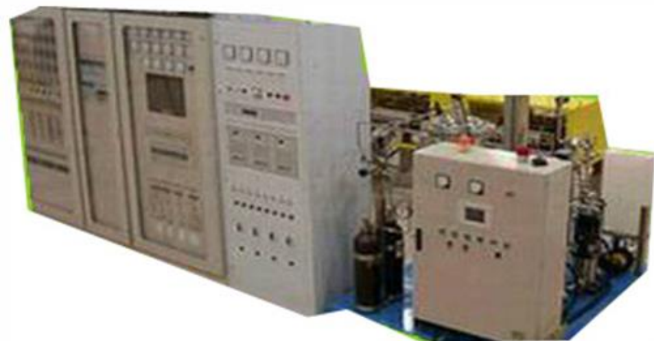
静止电压控制器 (SVC)
