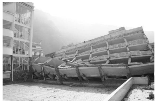
(b) 北面中央楼梯间西侧走廊倒塌破坏
