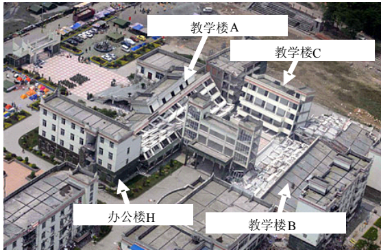
图 1 漩口中学震害总体情况(新华网陈树根摄)
