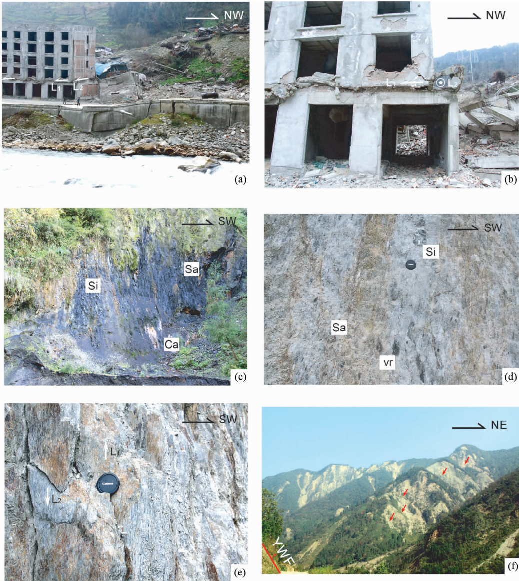
图1 映秀-北川地震断裂带的同震破裂现象
