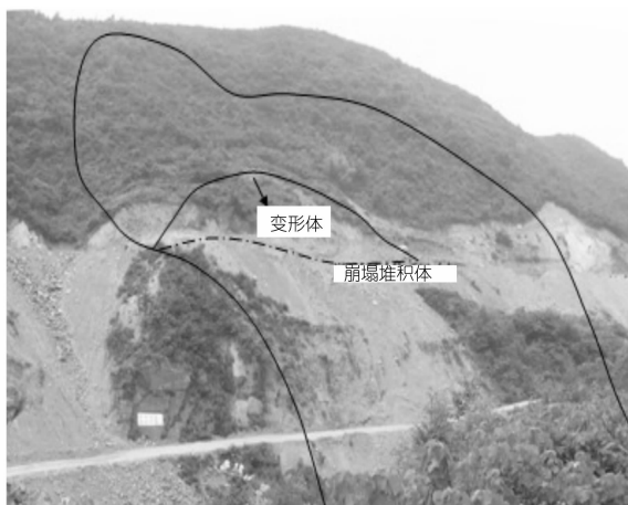
图 1 崩塌堆积体及变形体全貌
