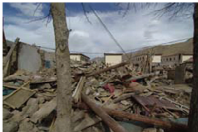
图 15 1层家属楼整体倒塌
