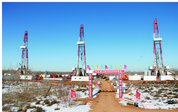
图2 DP43井组现场照片
