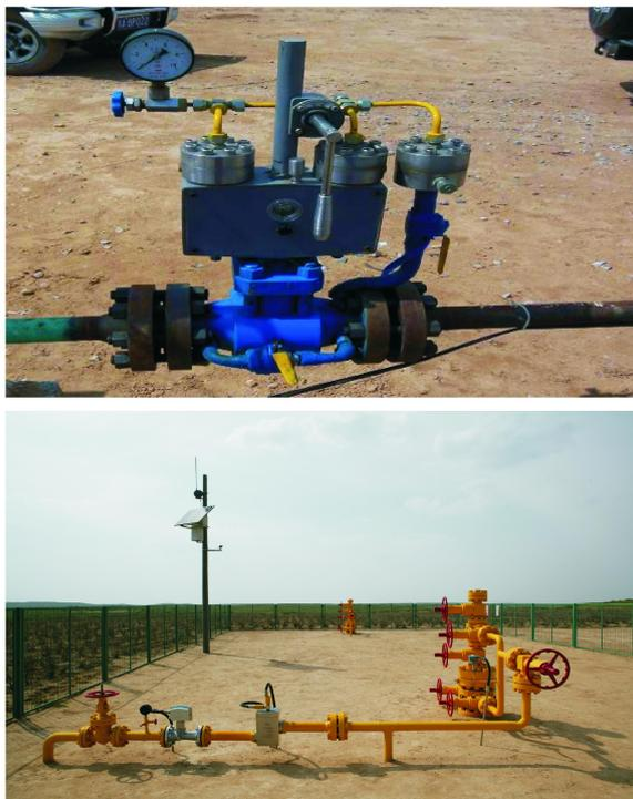
图2 井口紧急截断阀、井场流程图
