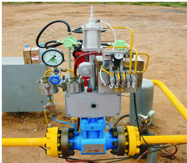
图2 井口数据传输系统图
