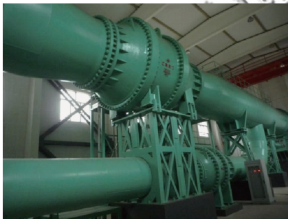
图 13 主调压阀+旁路阀
