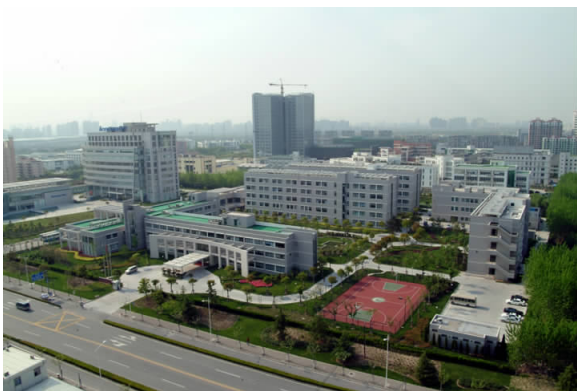
图2 上海药物所浦东新园区
