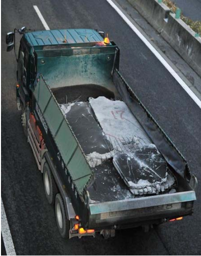
图 4 运出现场的混凝土顶板
