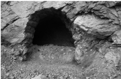
(a) 洞前塌方清理后的坑道出口成型情况
