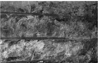
(b) 洞壁预裂成型情况
