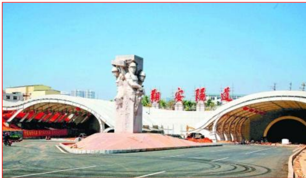
厦门翔安隧道
