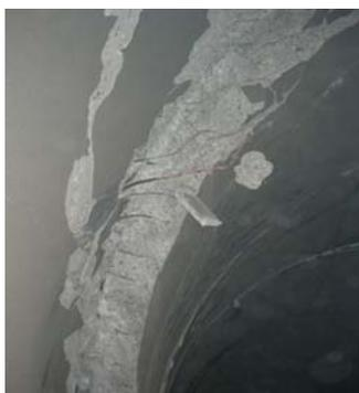
图 3 龙溪隧道衬砌发生错台<sup>[4]</sup>
