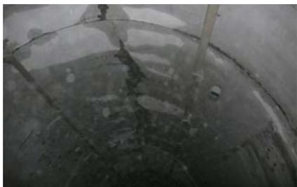
图 2 龙池隧道洞内拱部纵、横向开裂<sup>[4]</sup>
