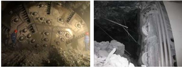
图5 TBM掘进通过半导洞
