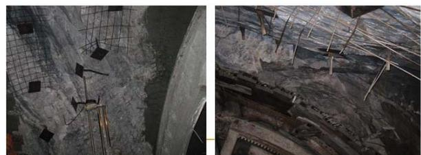
图7 现场实际发生的中等岩爆情况
