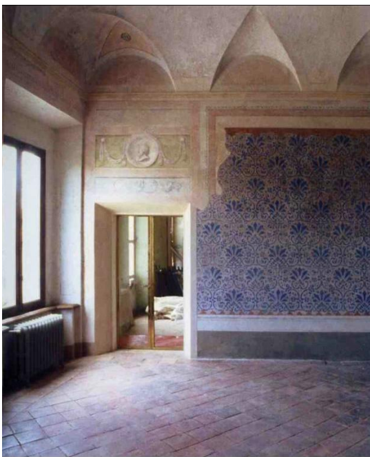
图 9 贡扎加宫室内: 多个时代的墙面装修并置, 原始地板被重新挖掘出来
