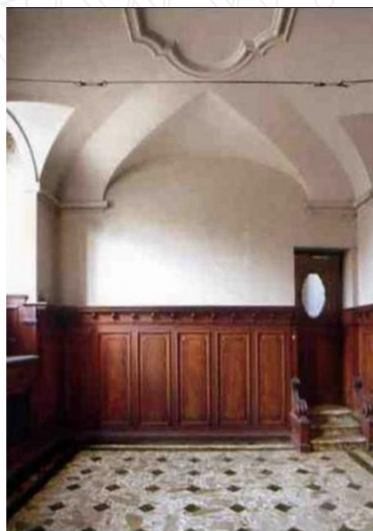
图 5 改造前的室内装修
