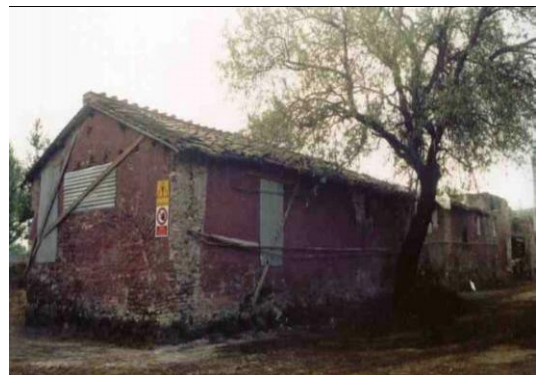
图 10 “红房子”老年中心建筑原貌
