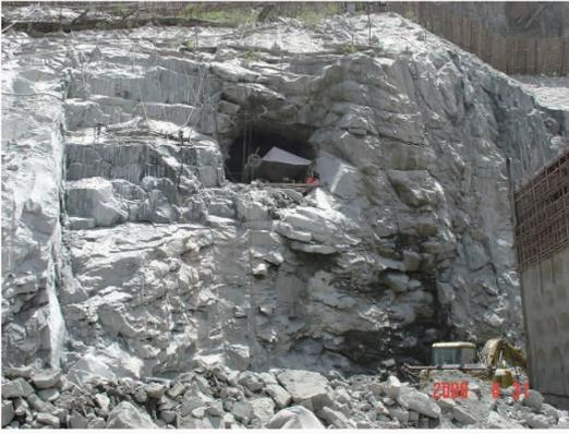
图4 左岸坝基下游侧缺陷槽开挖
