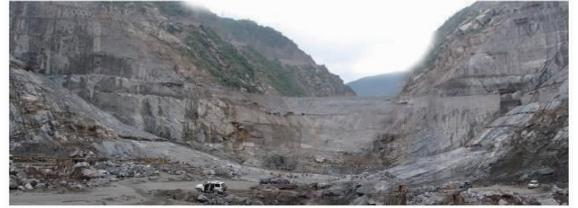
图 1 小湾水电站河床坝基开挖面貌及浅表部近似平行建基面的缓倾角卸荷裂隙
