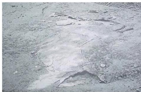
图3 右岸建基面 962m 高程发生的岩爆
