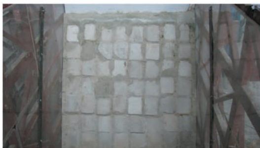
图5 硬岩边坡砌筑
