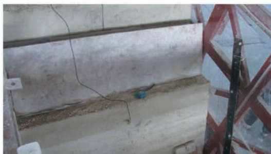
图4 软岩边坡砌筑
