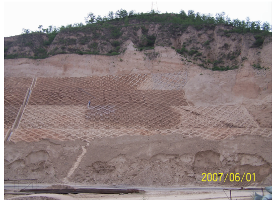
图 1 王良寺滑坡治理工程概貌
