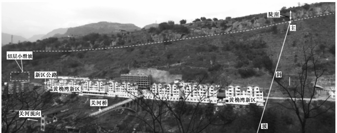
图 1 黄桷湾危岩高边坡全貌
