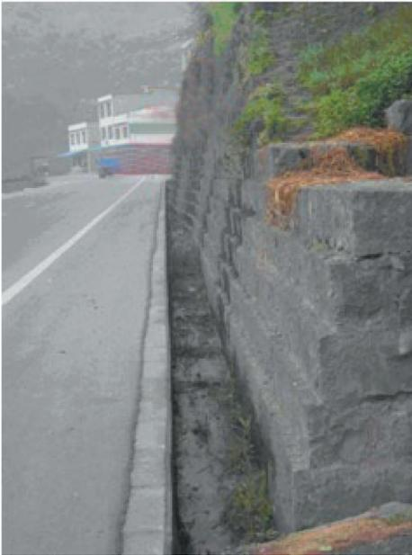
图5 下滑体前缘前缘挡墙鼓胀变形
