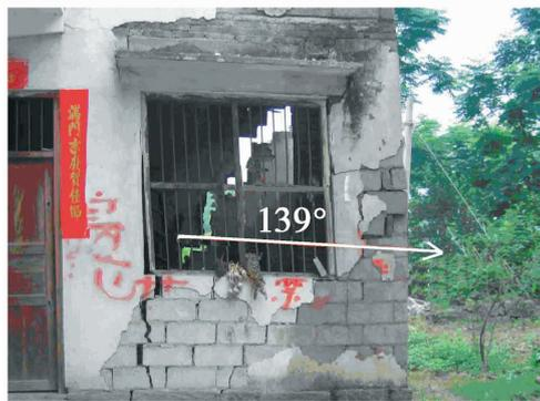
图1 下滑体后部变形开裂的房屋
