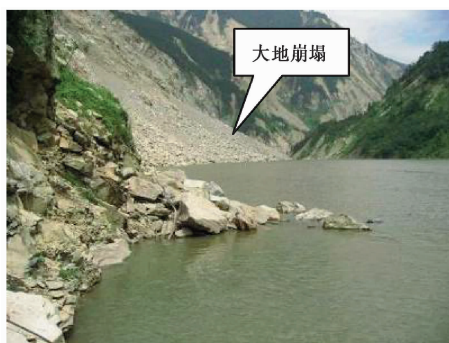
图 5 大地崩塌堵塞渔子溪
