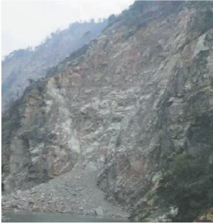
图3 块状岩质边坡滑移式垮塌
