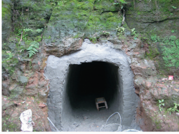
图6 抹混凝土后的隧道模型
