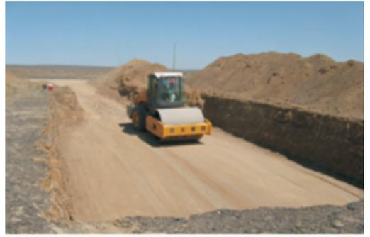
图9 回填碾压试验
