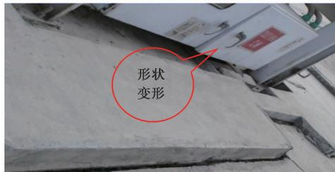
图 1 某开关站溶陷变形
