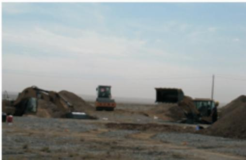
图8 回填碾压试验
