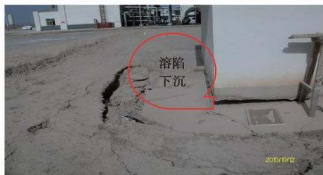
图 2 某钾肥厂建筑物溶陷变形
