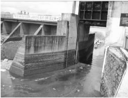
图 1 既有临海混凝土水闸工程
