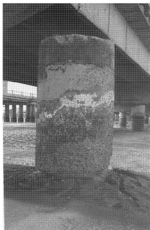
图 5 桩基冻拔现象
