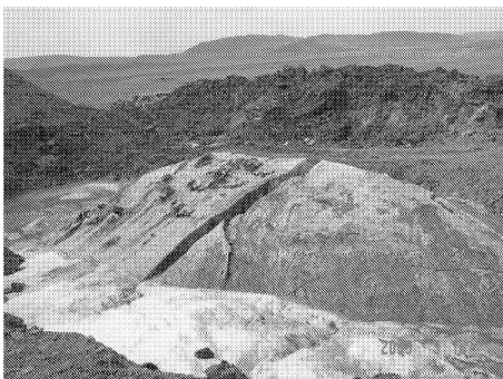
图9 桥位处冻胀丘
